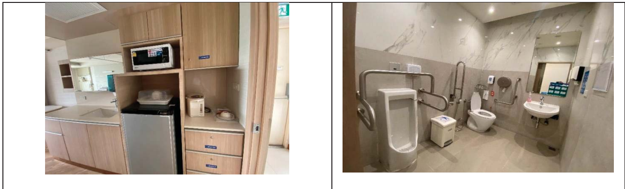
รูปที่ 2-16 อุปกรณ์ประหยัดไฟเบอร์ 5 และการเลือกใช้โถสุขภัณฑ์แบบประหยัดน้ำ
